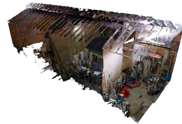
OG Scheune, innen
