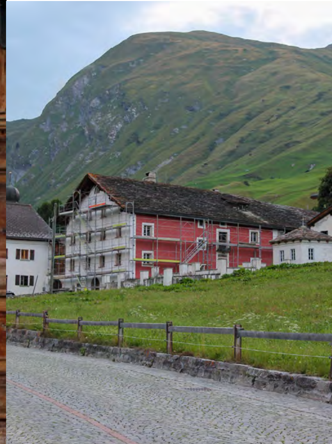
Bild 47: Das «Rothuus» während Sanierungsarbeiten, Sommer 2025
